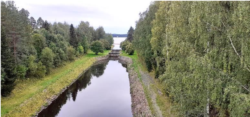
Kuva 28. Ahkiolahden vanha kanava
